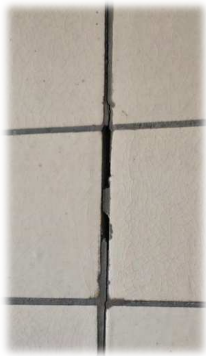
Réparation de fortune dans le but d'éviter l'effondrement des murets de séparation fissurés dans les sanitaires
